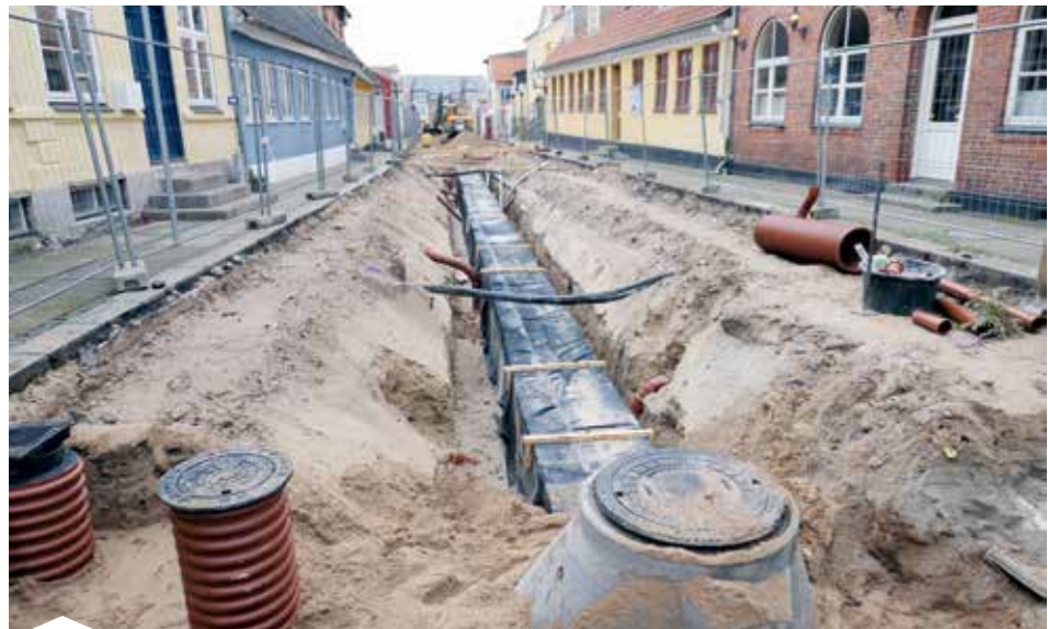
Figur 4: I områder, hvor nedsivning ikke er muligt, kan Rockflowkloakken pakkes ind i en tæt membran. Afvanding sker til recipient.
