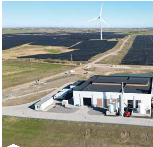
PtX anlægget i Ramme.
