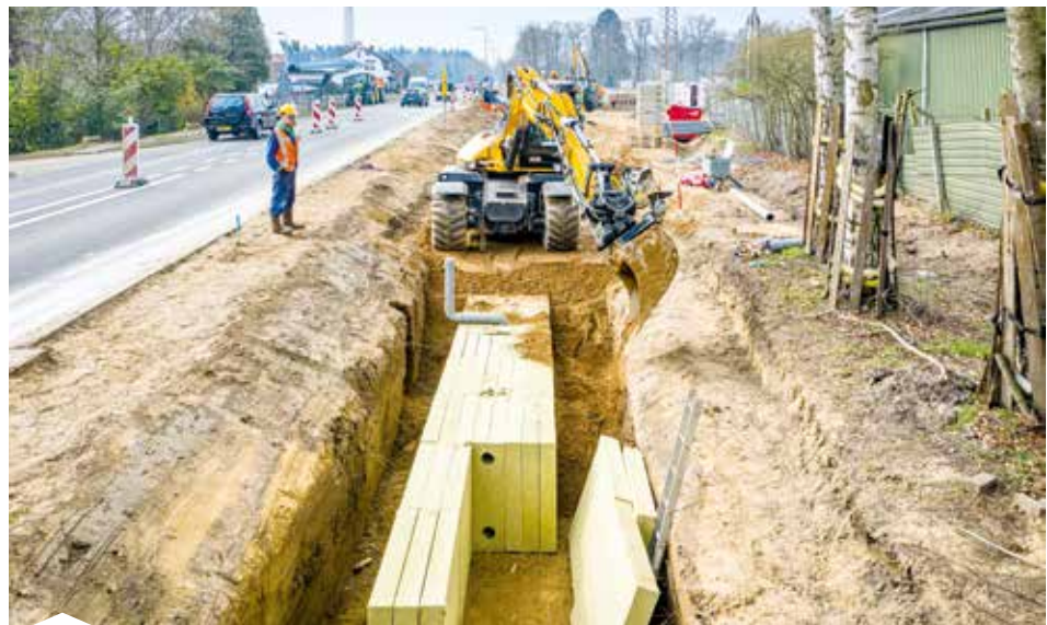
Figur 5: En Rockflowkloak - 1,5 km lang anlagt under cykelsti i byen Barlo, Holland.
