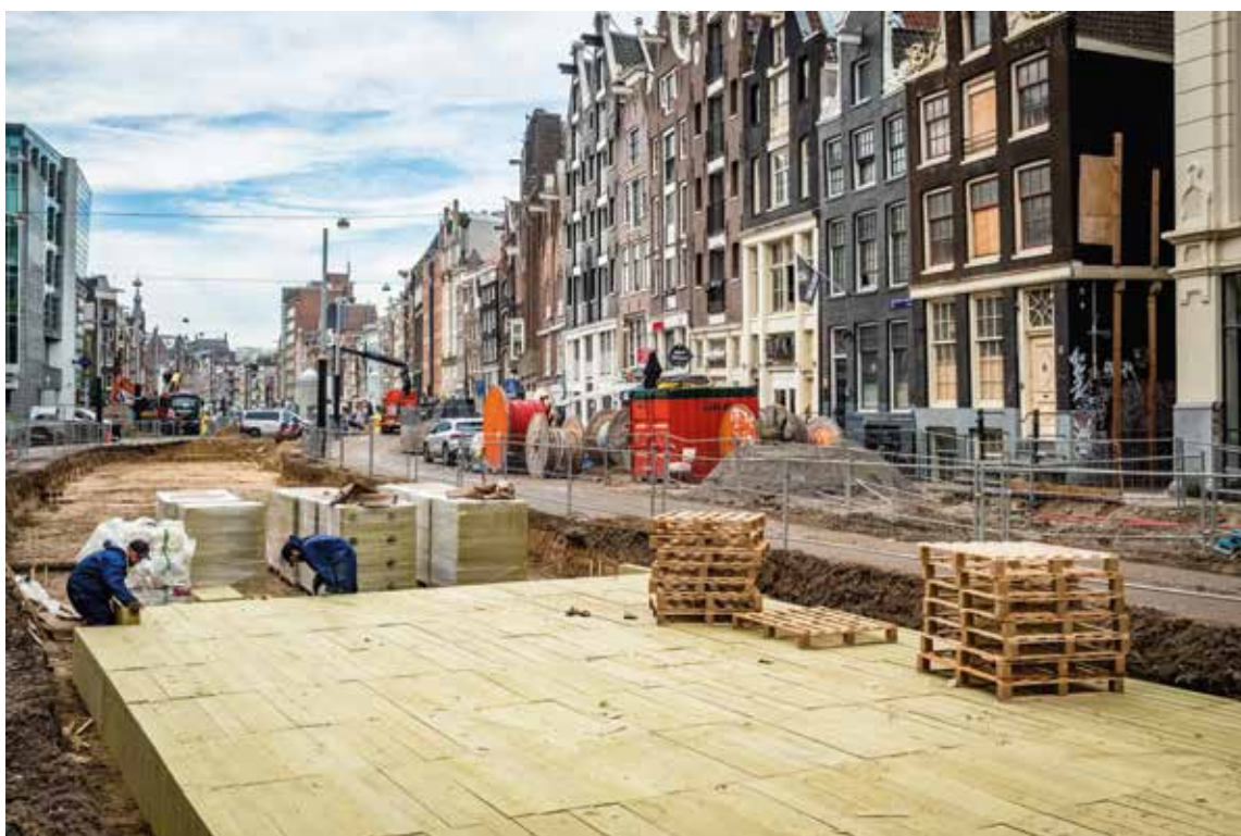
Figur 1: Et magasin til regnvand bygget af Rockflow elementer anlagt under letbanen igennem Hollands hovedstad Amsterdam.
