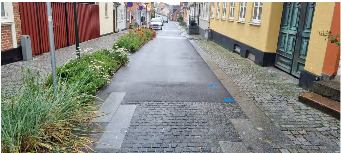
Figur 1.4.3.3.1: Eksempler på vejbede.
