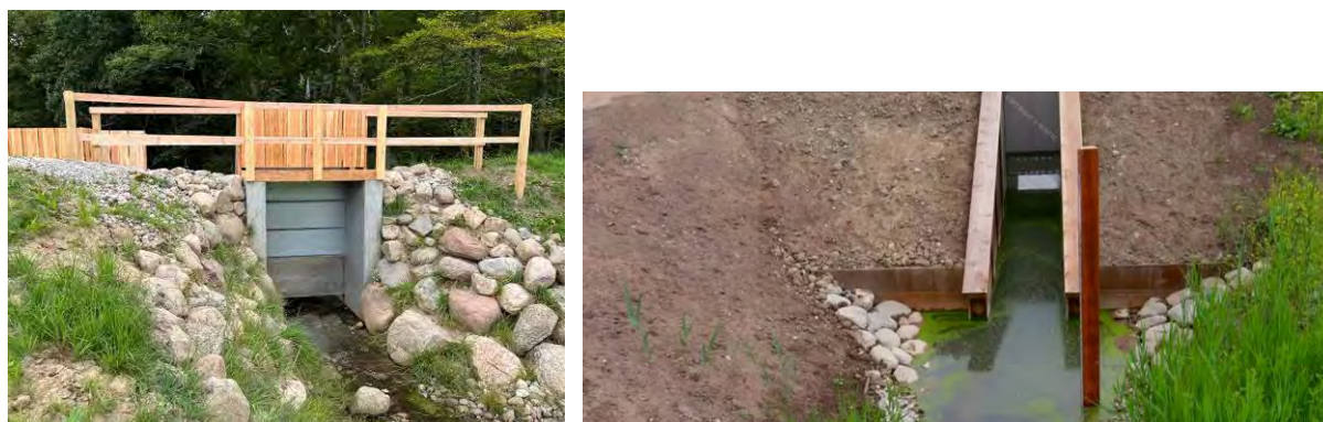
Figur 1.5.4.1: Eksempler på sluse/stigbord løsninger /Wintec/
