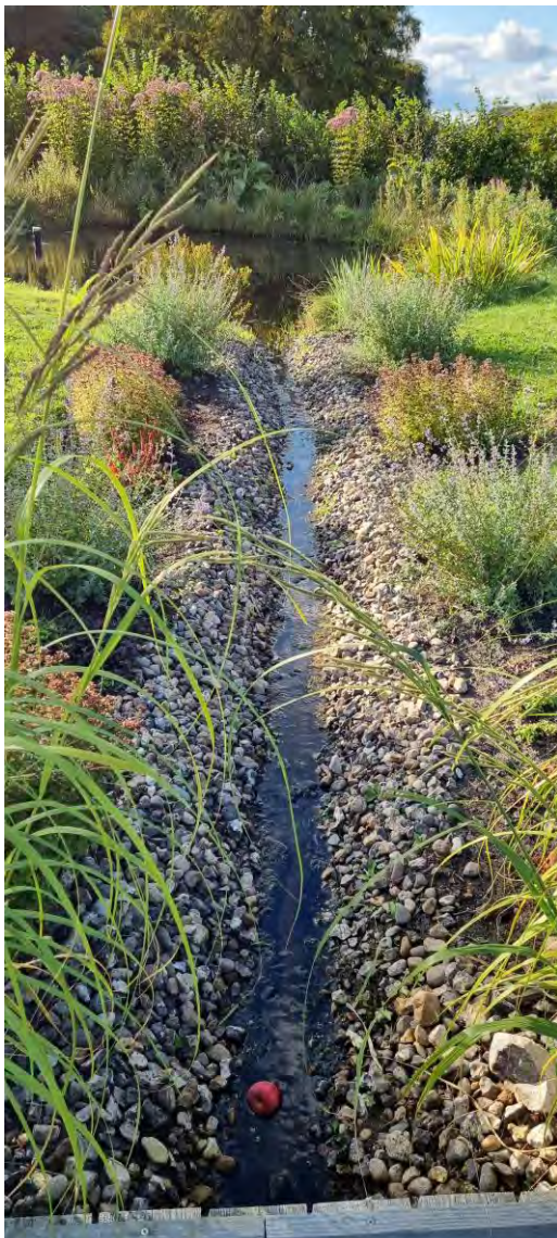
Figur 1.4.3.5.1.: Foto – eksempel på grøft med dobbeltprofil (i normal situationen vil grøften være tør) og princip-snit for udløbsbrønd for enden af en grøft med overløbsmur inden udløb til å-dalen i det grønne hjerte. Der monteres ikke vandbremse i brønden.
