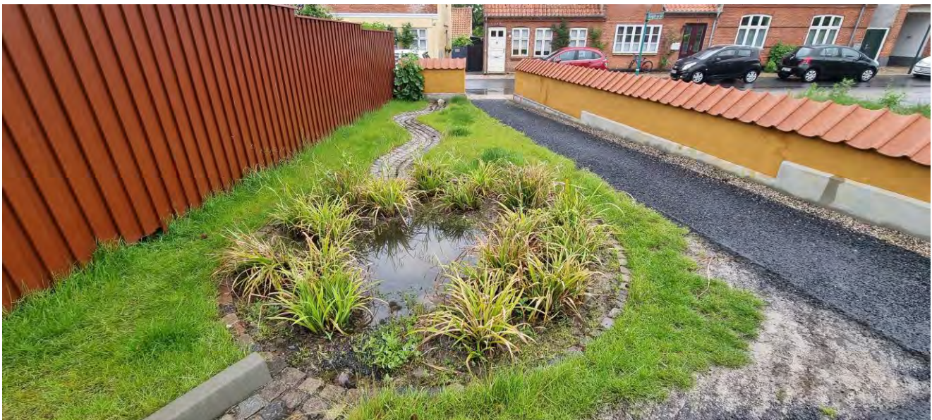
Figur 1.4.3.3.3: Eksempel på lokal opsamling i af regnvand i byrum.
