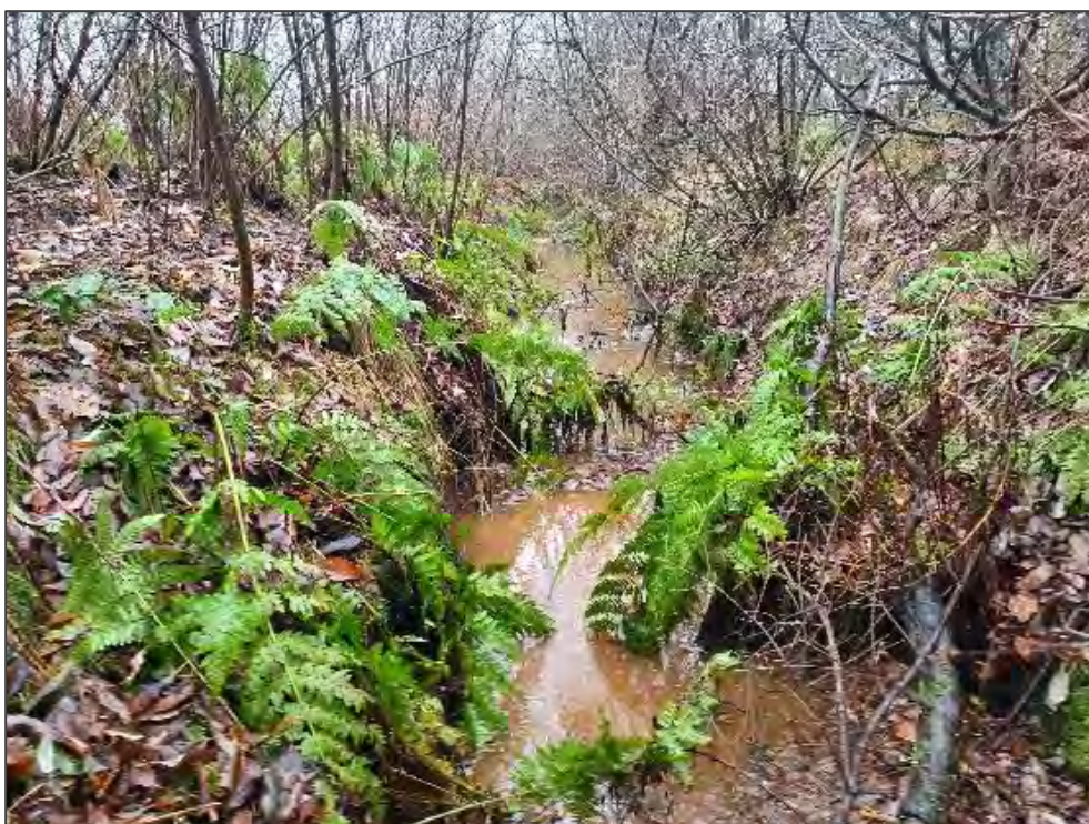
Figur 1.2.2.2: Åben okkerpåvirket del af hovedræn umiddelbart nedstrøms Nordmarksvej.
