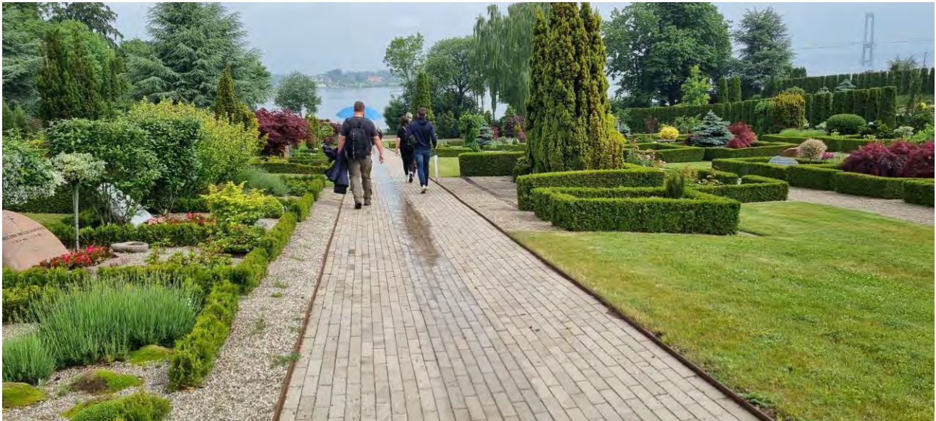
Figur 1.4.3.3.4: Eksempel på kantzone, der styrer vandets strømning på overfladen.
