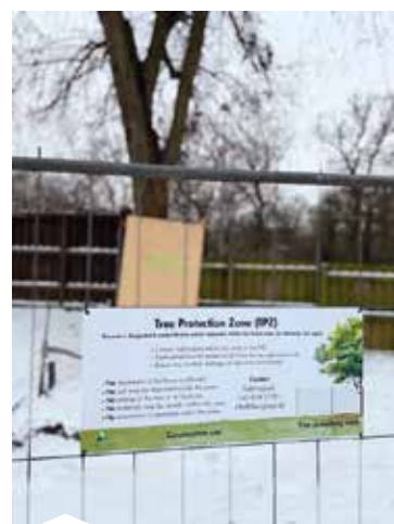
Opsætning af stammebeskyttelse og hegn omkring træets beskyttelseszone, med tilhørende skilt.
